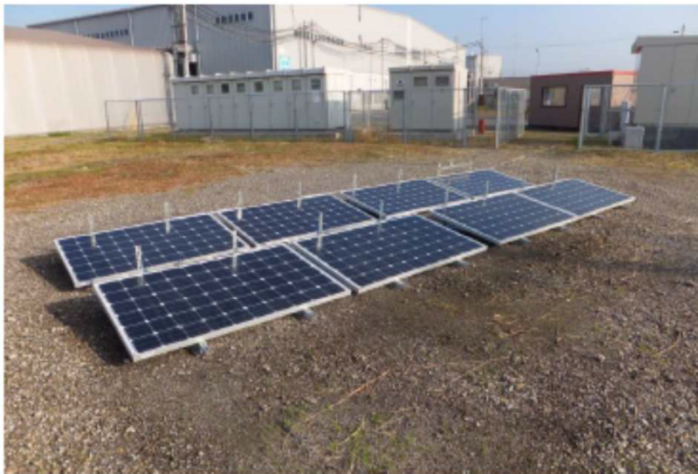
使用済PVパネルの設置写真 (8枚セット)
