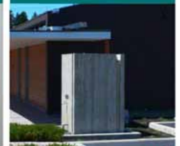
雨水貯留槽による雨水利用
