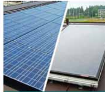
太陽光発電・太陽熱集熱パネル
